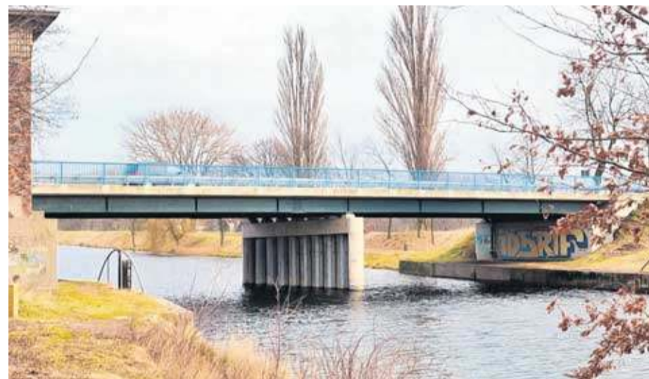
Ein Brückenbau hinter Günthersdorf auf sachsen-anhaltischer Seite. Südlich von Kreypau ist auch noch eine unvollendete Brücke zu entdecken, die durch den Baustopp am Kanal 1942 aber nur über einen trockenen Erdbereich geführt hätte.
