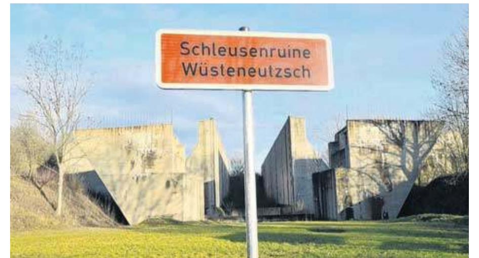
Die Schleusenruine bei Wüsteneutzsch: Die Schleusentreppe ist eine von nur wenigen ihrer Art in Deutschland. Projektiert waren zwei baugleiche Schleusenkamern, von denen heute nur die obere zu sehen ist. Für den Bau der unteren Kammer wurde bis zum Baustopp nur die Baugrube ausgehoben.
