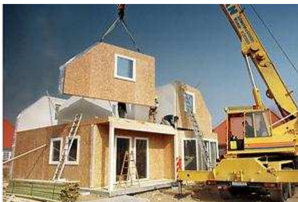
Rohbau eines Einfamilienhauses
