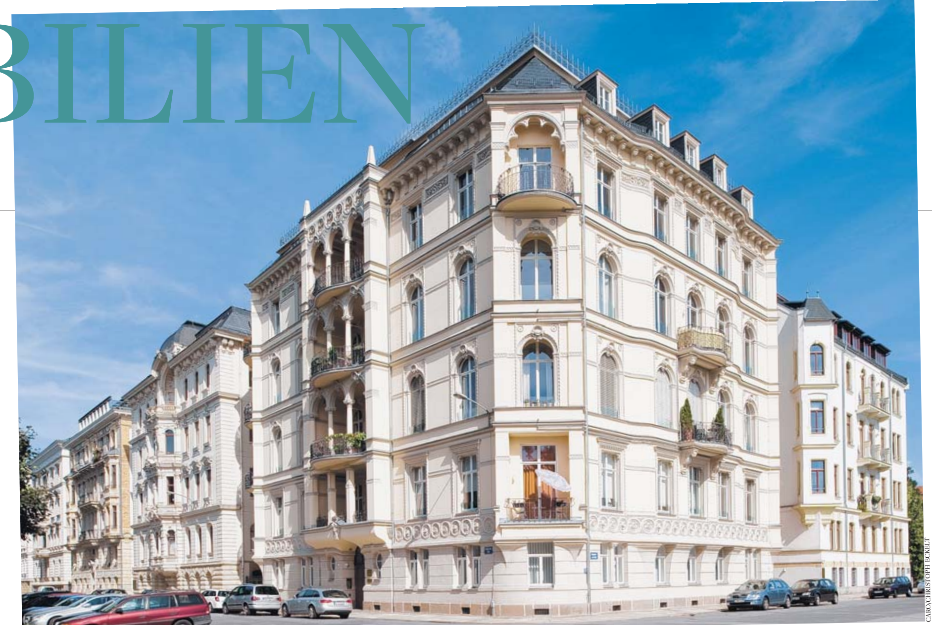
Noch relativ günstig: Sanierte Gründerzeitbauten im Musikerviertel Ecke Haydnstraße/Schwägrichenstraße
