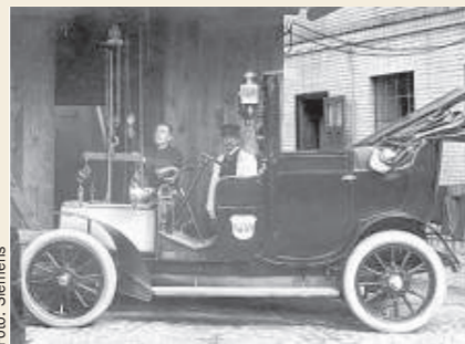
Bereits 1905 drehte die elektrische Viktoria ihre Runden durch Berlin. Das in den Siemens Autowerken gebaute E-Taxi war 30 km/h schnell und kam 80 Kilometer weit.
