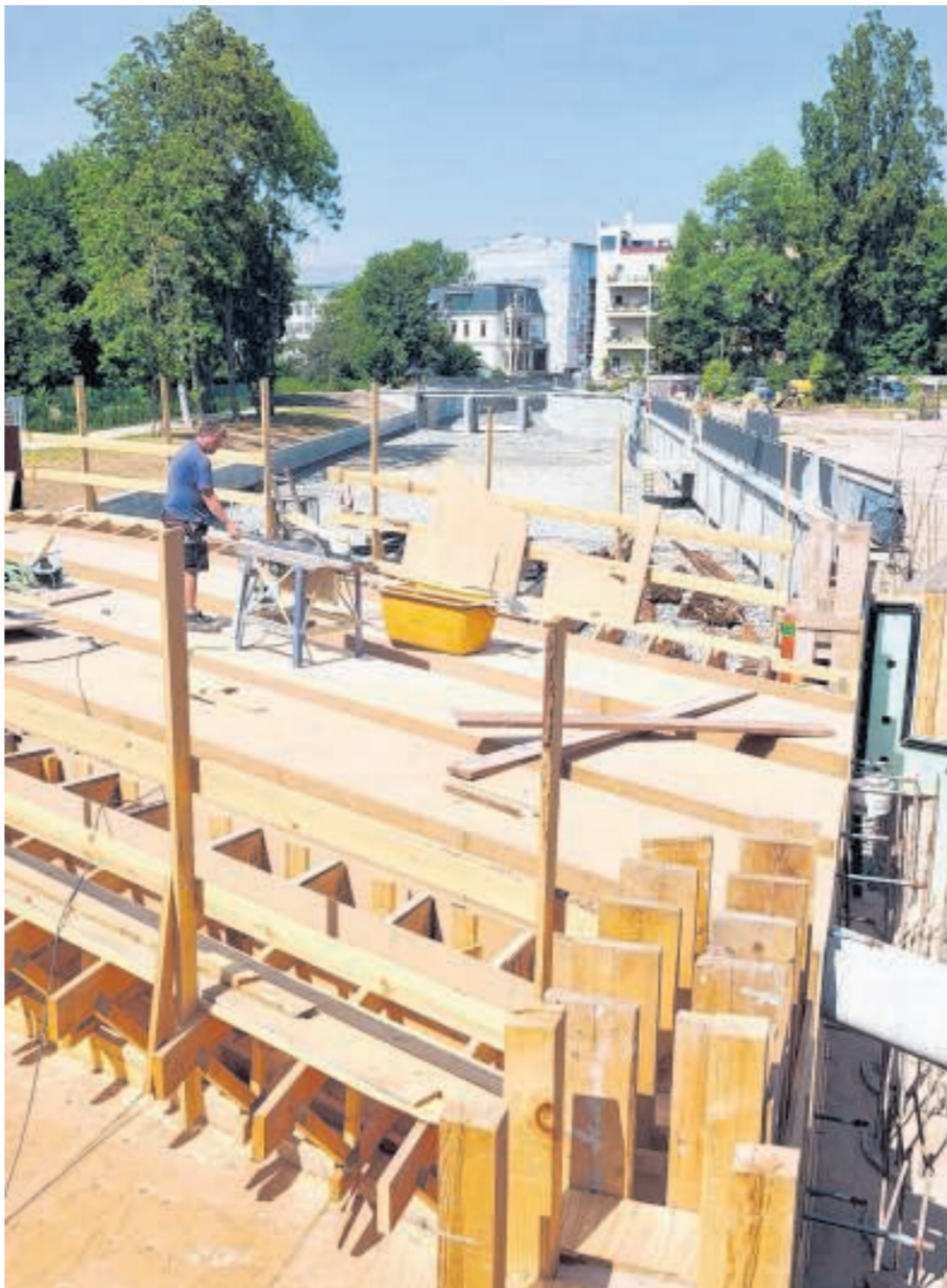
Der Ausbau des Elstermühlgrabens zwischen Schreiber- und Friedrich-Ebertstraße ist fast abgeschlossen. Rechts davon entsteht der Stadthafen. Foto: Wolfgang Zeyen
